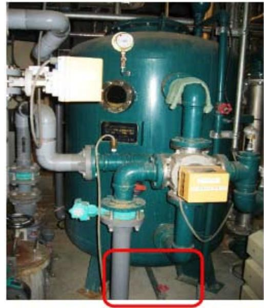
ろ過器内を効率良く「消泡」する為に、消泡剤 CALFA BAT（カルファバット）をヘアーキャッチャーに投入します。大型のろ過器であれば、キャップ2杯。小型であればキャップ1杯くらいで結構ですので、事前に水で5倍希釈（薄める）して投入して下さい。さて、排水が終わり、沈殿物を洗い流したら、再び開いた全てのドレン・浴槽の共栓（ともせん）を閉めて水（湯）を張ります。「逆洗浄」が出来るだけの水位にまで水を貯めて、手動で短時間、逆洗浄しますと、「ろ過器→浴槽」までの配管にある洗浄水を効率良く排水出来ます。次に、新しい水を張り、循環させ「すすぎ洗い」を行います。通常はこれで終了ですが、泡切れが悪い時、ジャグジー等水の乱流が起こる設備に関しましては、ごく微量のNAC成分が残っていても「泡」が残ります。その際は、もう一度、すすぎ工程を繰り返して下さい。
