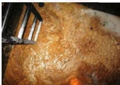
貯湯槽内部のバクテリアも分解洗浄
