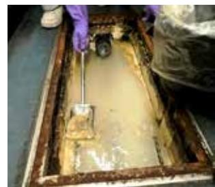
グリストラップ内の状態が悪かったのでグリスト・アタック5%ずつ計3回に分けて15%の水溶液をバケツにお湯で投入
